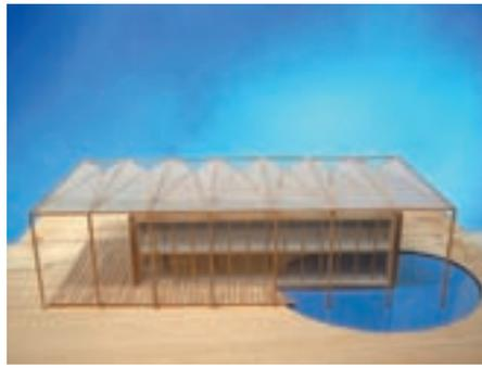
Das Dach ist eine Membrankonstruktion, die vom restlichen Gebäude entkoppelt ist. Sie ist so konzipiert, dass sie optimalen Witterungsschutz bietet und eine variable, der Jahreszeit angepasste Beschattung ermöglicht.
