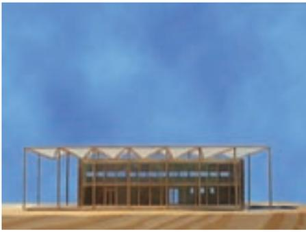
Die Nord-Süd-Ausrichtung mit der südseitigen Glasfront und den eingebauten Sonnenkollektoren sowie dem vorgelagerten Teich dient der optimalen Nutzung der Sonnenenergie. Die Beheizung des gesamten Gebäudes kann über das ganze Jahr mit dieser erneuerbaren und kostenlosen Energiequelle bewerkstelligt werden.
