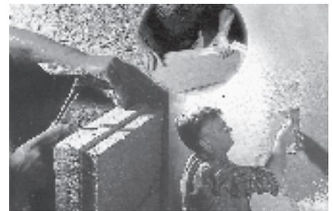
Lehm-Hanffaser-Ziegel besitzen einen exzellenten Schalldämmwert sowie ein hohes Wärmespeichervermögen; außerdem können Materialreste im Zuge von Leitungsinstallationen wieder zum Ausfüllen der dabei entstehenden Spalten verwendet werden, d.h. bei diesem Bauprodukt kann der sonst üblicherweise anfallende Bauschutt sinnvoll noch auf der Baustelle eingesetzt werden.
