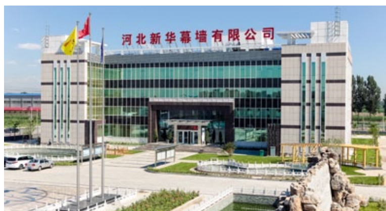
Büro-Passivhaus Zhuozhou/China, Foto: Schöberl & Pöll GmbH
