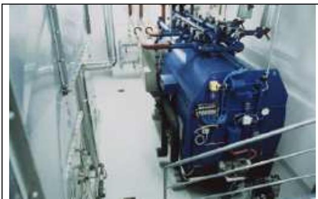
Adsorptionskältemaschine mit periodischer Betriebsweise mit Silikagel als Adsorptionsmittel und Wasser als Arbeitsstoff.
