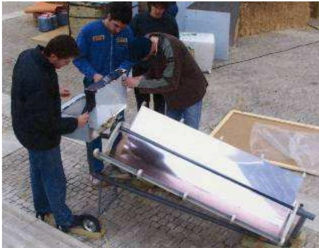
Abbildung 12: Bau eines Prototyps (Rinnenkollektor)<sup>20</sup>
