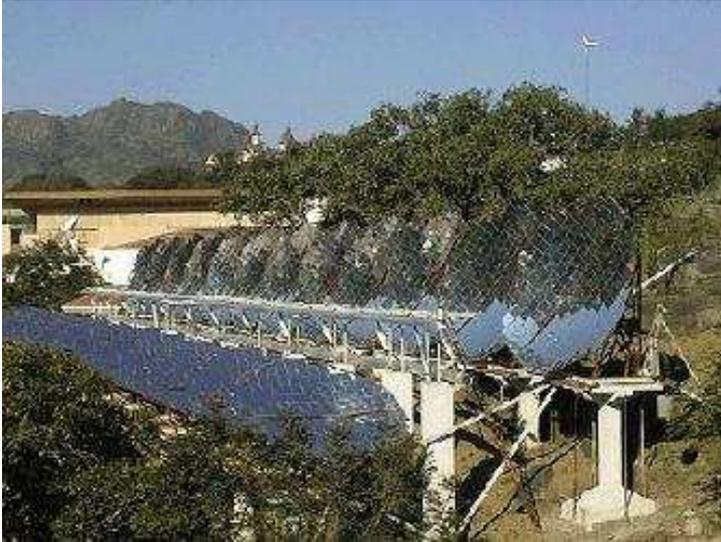
Abbildung 13: Fix-Fokus-Scheffler-Kollektoren<sup>24</sup>
