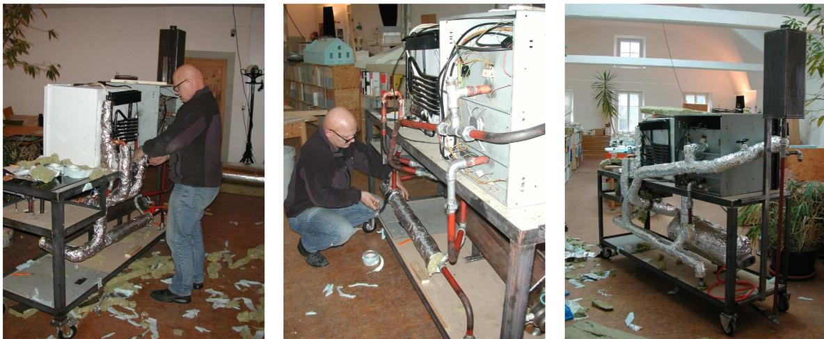
Abbildung 57: Anbringen der Isolierung der Thermoölversorgungsleitungen für Kühlgerät und Backrohr<sup>76</sup>
