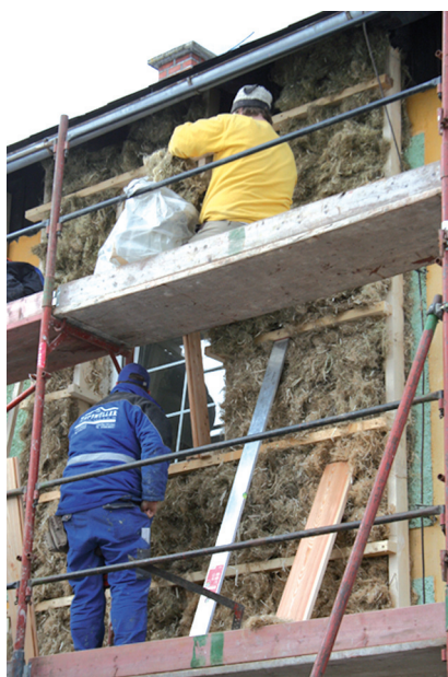
Kursteilnehmer dämmen die Außenwand mit Hanfstopfwolle
