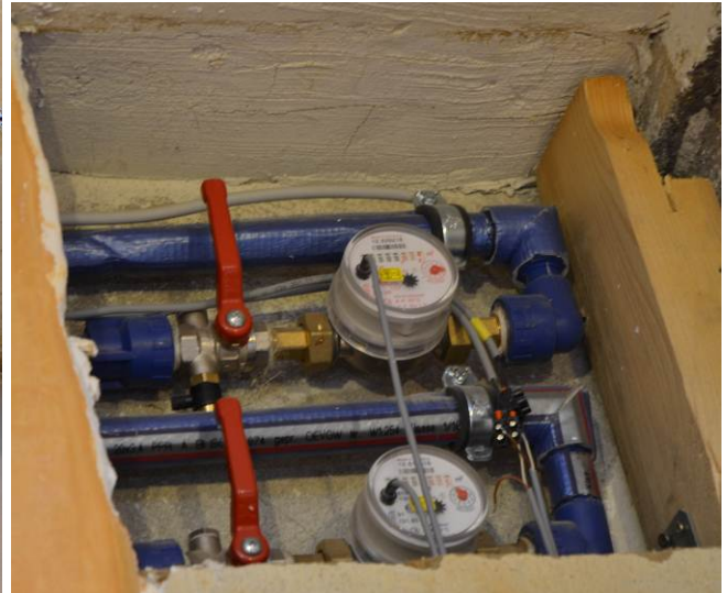
Abbildung 91: Links: Badbereich mit elektrischem Trockner, Waschmaschine, thermischem Trockner (v.l.o.); rechts: Anschlussleitungen mit Mengenzähler
