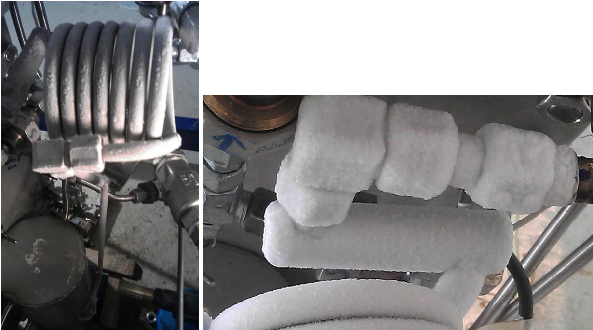
Abbildung 36: Links: Eisbildung am externen Spiralverdampfer; rechts: Eisbildung an der Zuleitung des Verdampfers
